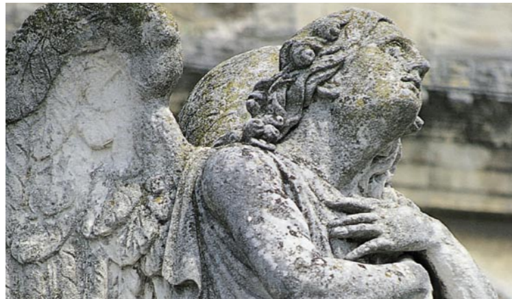
1 Verwitterungsschäden an einer Sandsteinfigur
